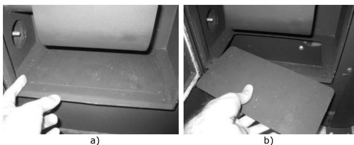
Figura 138 – Limpeza do interior da salamandra
